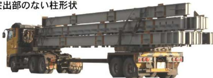
柱の輸送状況
