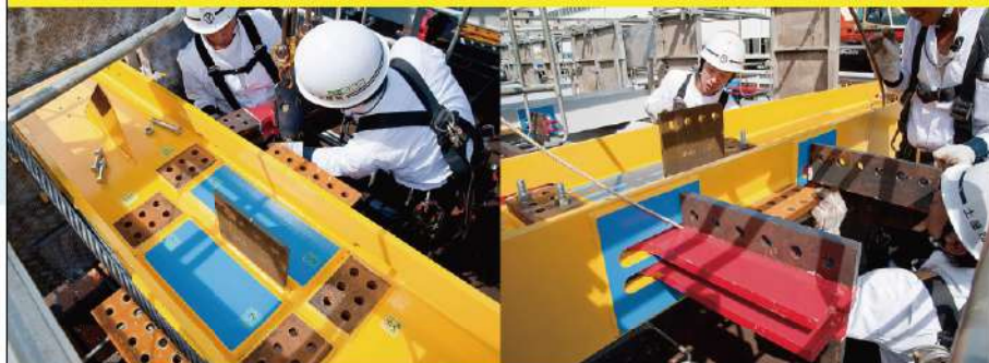
●接合金物取付け
