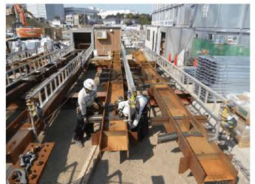
建方前の柱の状況
